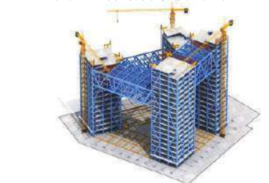
液压提升就位连接塔楼
