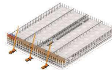
高空原位拼装第一段桁架
